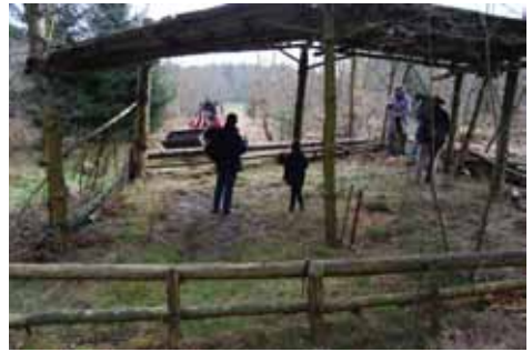
Reparaturen am Schafstall
